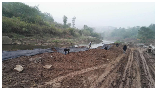
裸露地表覆盖
