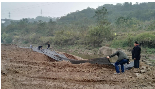
裸露地表覆盖
