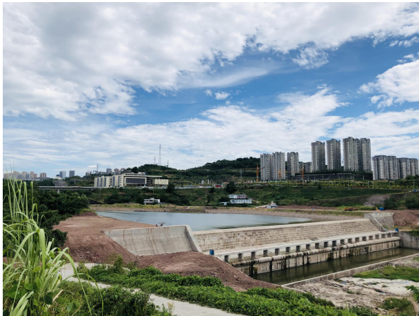
2#拦水坝（施工完）
