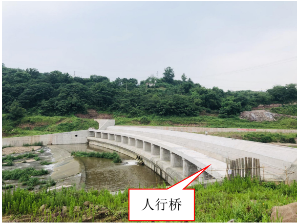
1#拦水坝（施工完）
