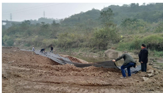
裸露地表覆盖
