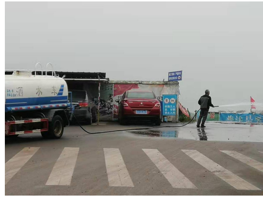
施工期间洒水降尘
