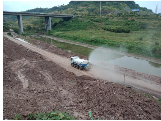
施工期间洒水降尘
