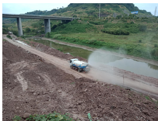
施工期间洒水降尘
