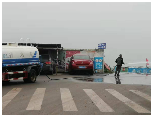
施工期间洒水降尘
