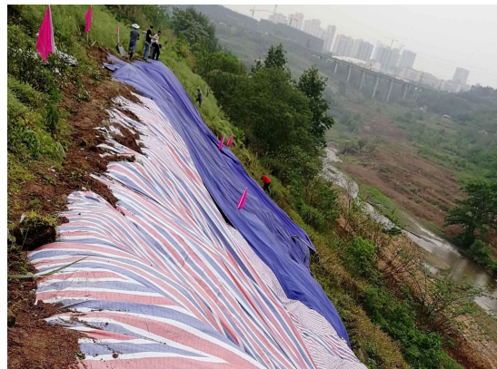
裸露地表覆盖
