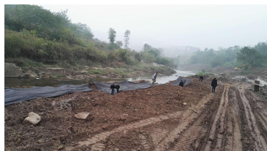
裸露地表覆盖
