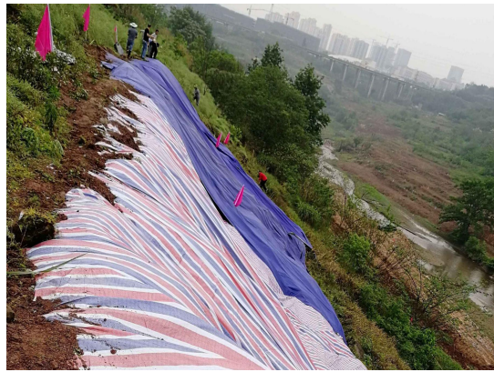
裸露地表覆盖
