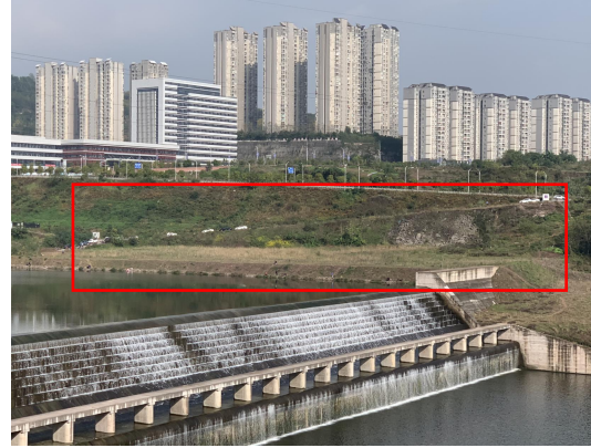
施工营地恢复情况
