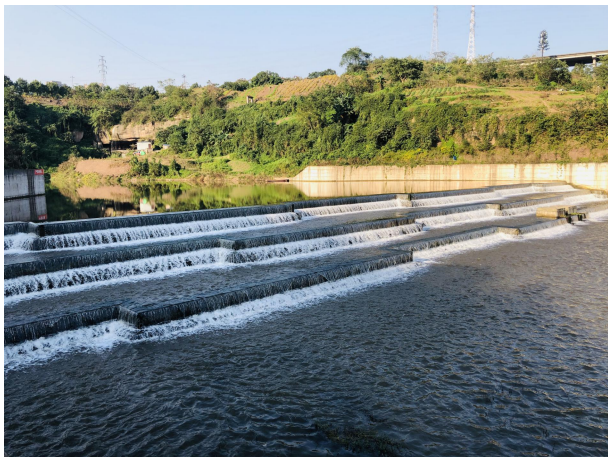
3#拦水坝（施工完）
