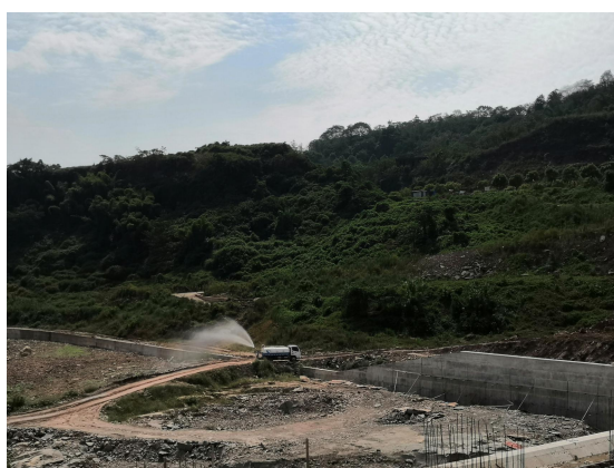
施工期间洒水降尘
