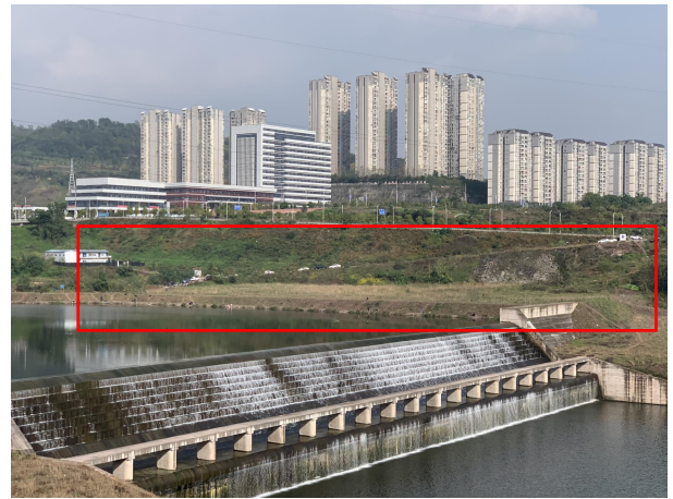
施工营地恢复情况
