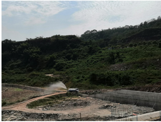
施工期间洒水降尘
